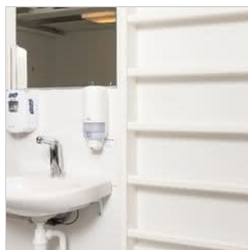
Wyposażenie łazienki dla niepełnosprawnych
